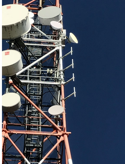
Obr. 7 – Vysielacie antény T-DAB+ na Panskom diele (pozn.: štyri zvislé tyče nad sebou na pravej strane obrázku)
